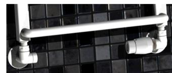
2. Při pohledu ve směru proudění teplonosné látky jde tato nejdříve do šroubení (nastavitelná hodnota kv), následně projde radiátorem, poté projde RTL ventilem, s hlavicí Vision RTL, a teprve poté jde buď do podlahového topení a nebo zpět ke zdroji tepla (viz obrázek vpravo)
